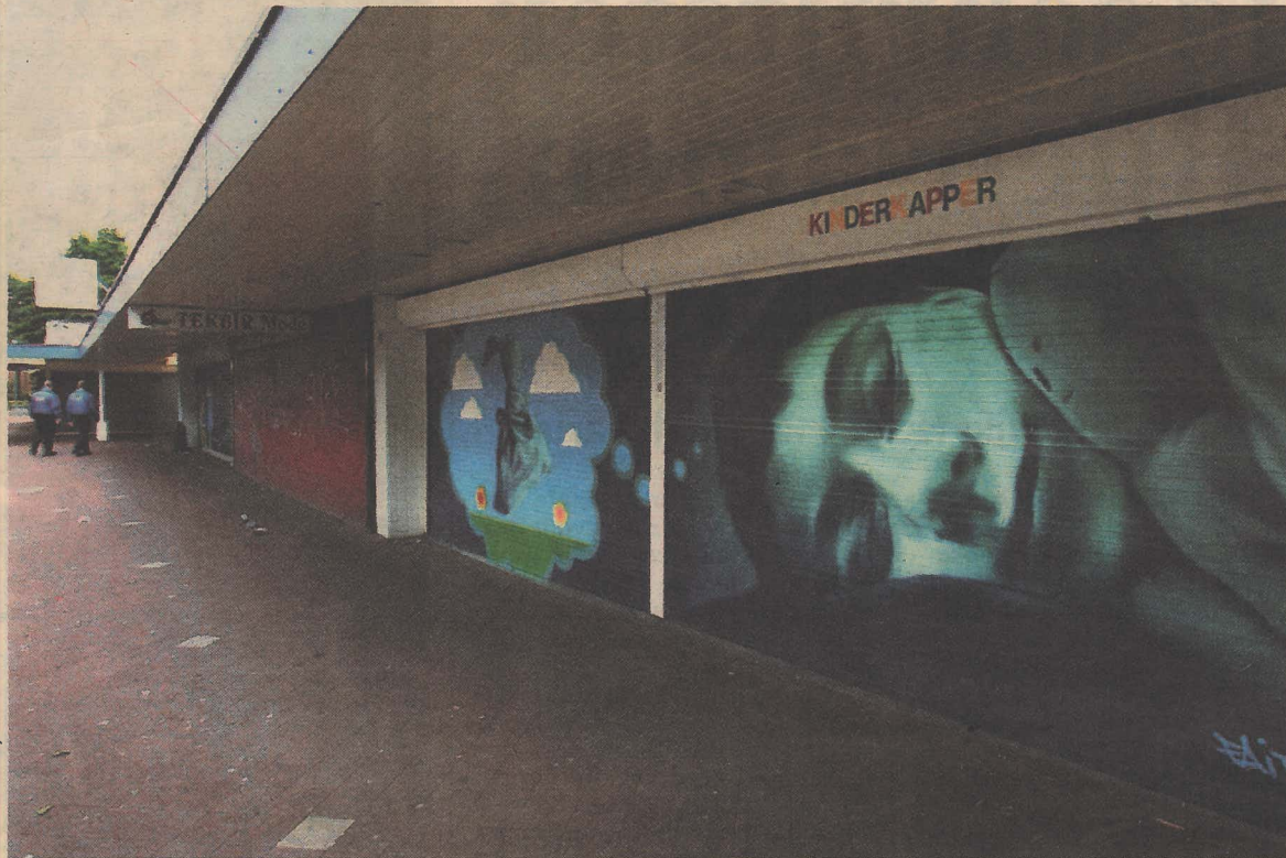
De rolluiken veroorzaken een troosteloze aanblik op het Waterlandplein.
